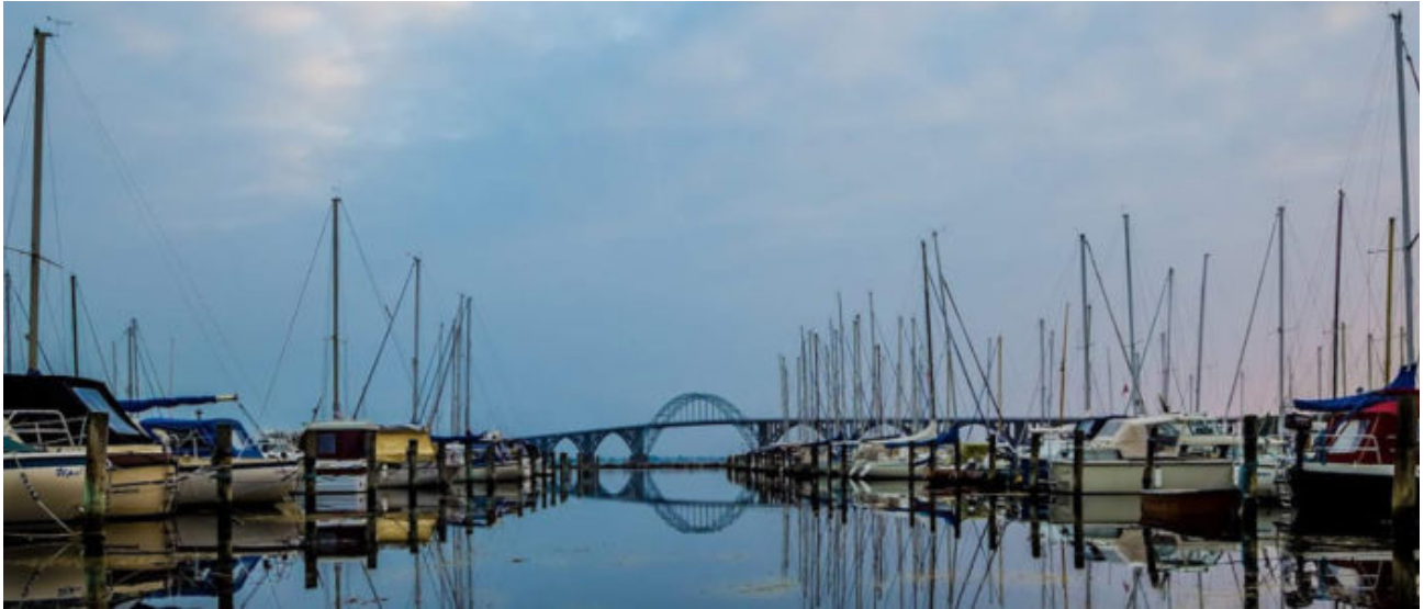
Foto: Dronning Alexandrines Bro (Mønbroen) set fra Kalvehave Havn
